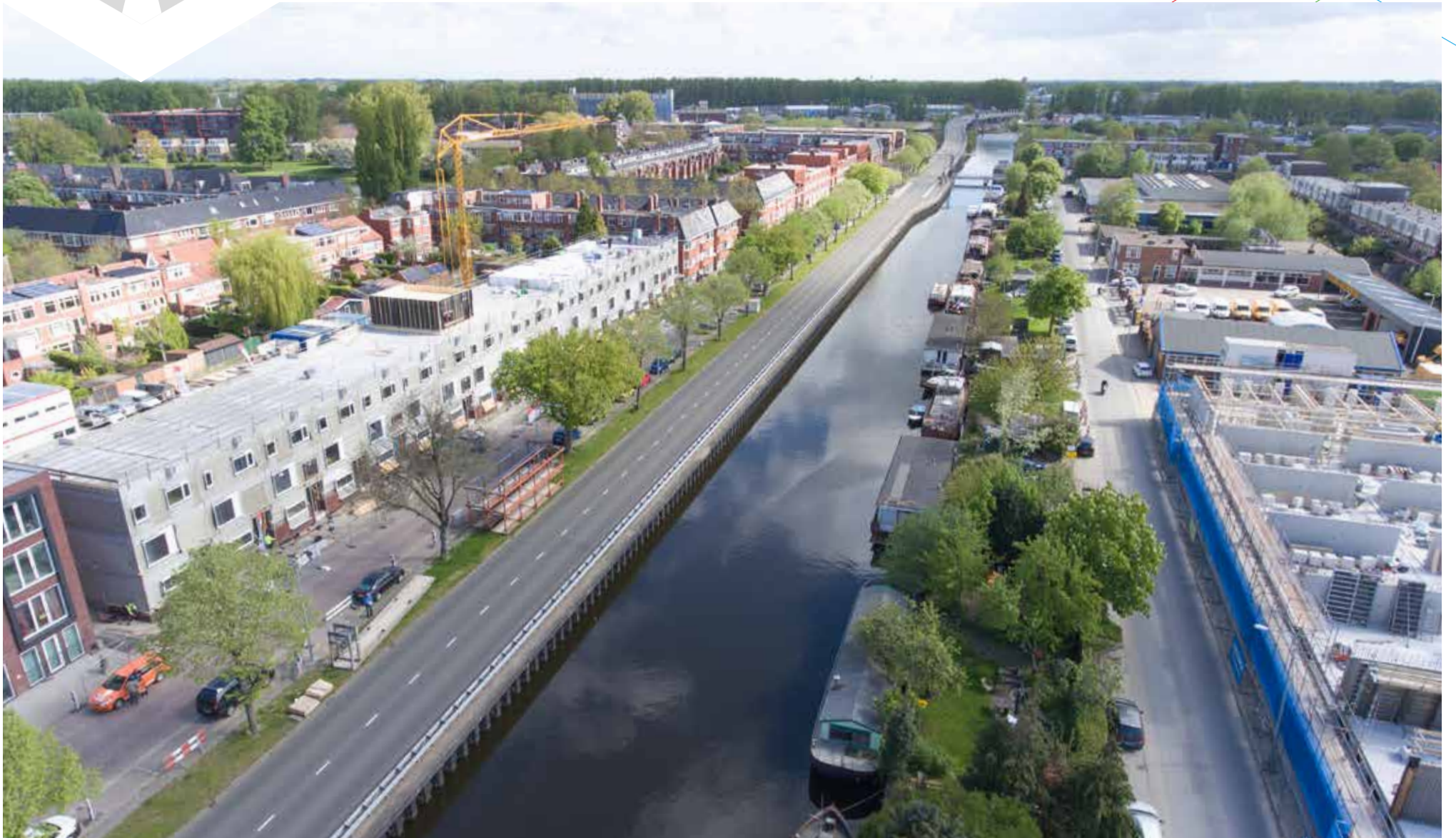
Bouw van de Stadsvilla's (links) en jongerenappartementen op de locatie Oude Taxicentrale (rechts) is in volle gang.
